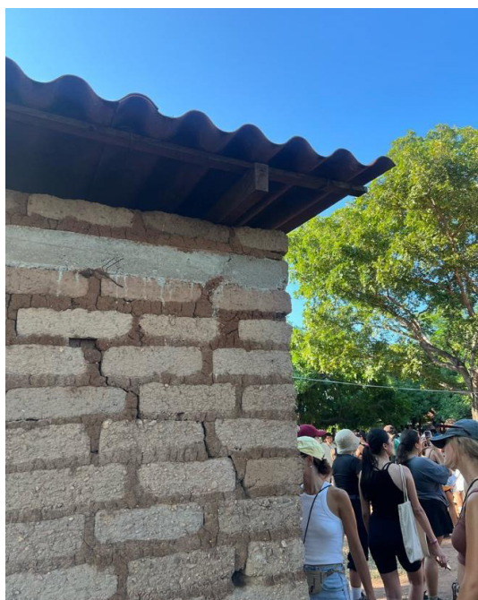
Figura 6. Casa de adobe con cerramiento de concreto y una cubierta de lámina de asbesto, 4 de octubre de 2025.
