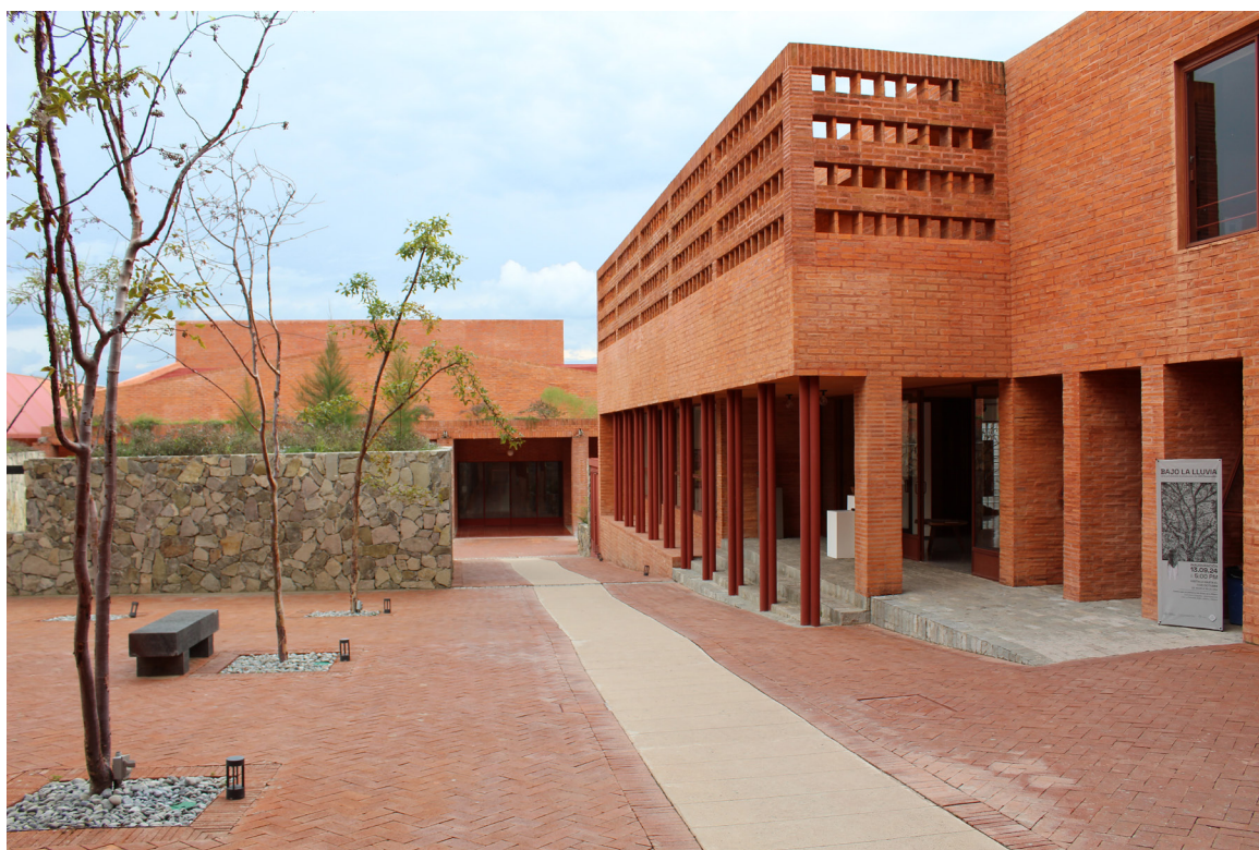
Figura 3. Al fondo se observa el perfil triangular del frontón del auditorio y la fachada del edificio administrativo, en la parte superior el muro de azotea se desarrolla con ladrillos formando una celosía para contener el espacio de exhibiciones y eventos. Fotografía tomada por la autora, septiembre 2024.
