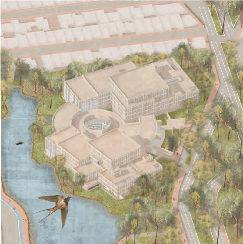
Vista Aérea de la Sala de Conciertos
