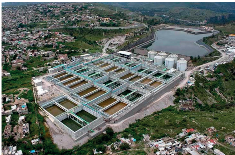
FIGURA 2.28 Planta de Tratamiento Agua Prieta
