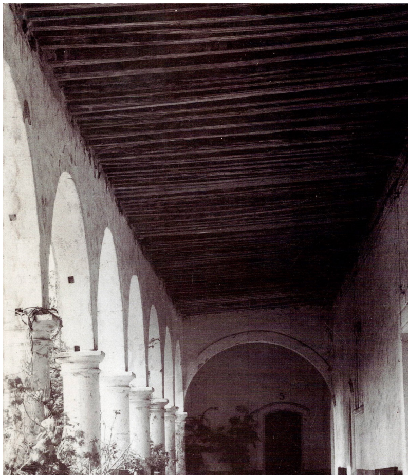
Ilustración 10. Corredor oriente viendo hacia el corredor norte en los años 50's del siglo XX, donde se observan las vigas de madera de la cubierta de terrado. Fotografía de M. Calvario. Tomada de la revista Sayula editada en abril de 2011.
