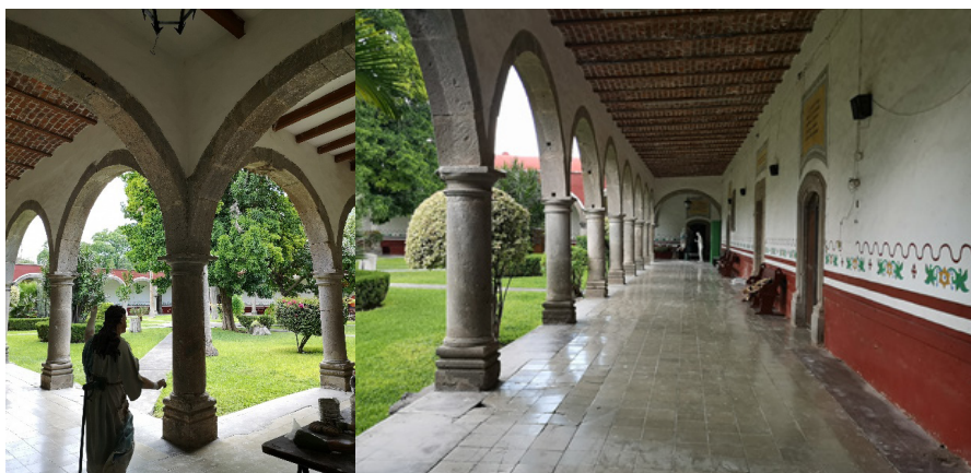
Ilustración 12. Izquierda. Vista de la bóveda del corredor norte que ha sido reforzada y aplanada, mientras que en el corredor oriente muestra bóveda de ladrillo de cuña. Derecha. Otra vista del corredor Oriente hacia el corredor norte. Las fotografías son del autor.
