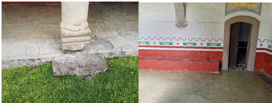
Ilustración 11. Izquierda: Vista de una columna con recalce para incrementar su estabilidad y capacidad de carga. La basa se recortó para imprimirle continuidad a la banca. Derecha: Bancos de mampostería adosados al muro del corredor norte, conservados como testigos cuando se retiraron los de los corredores oriente, poniente y sur. Fotografías del autor.
