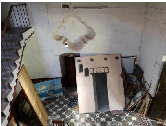
Ilustración 4a. Ojo de buey poli lobulado que indica la vinculación de la base de la torre con un espacio al aire libre. Fotografía del autor.
