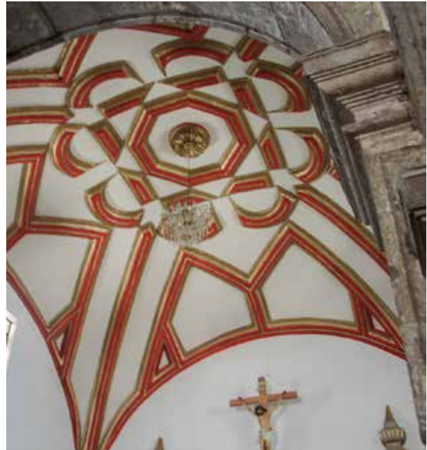
Figura 109. Cubierta del presbiterio en San Sebastianito. Fuente: Elaboración propia, 2008.
