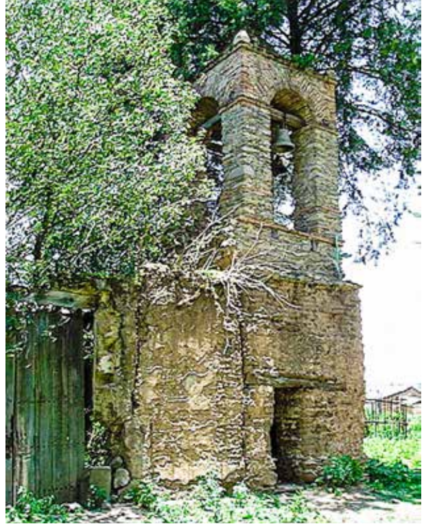
Figura 82. Hospital de Ataco. Fuente: R. Gutiérrez.
