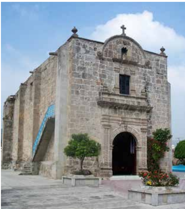
Figura 129. Contrafuertes en la capilla de Hospital de Tlajomulco. Fuente: Elaboración propia, 2008.
