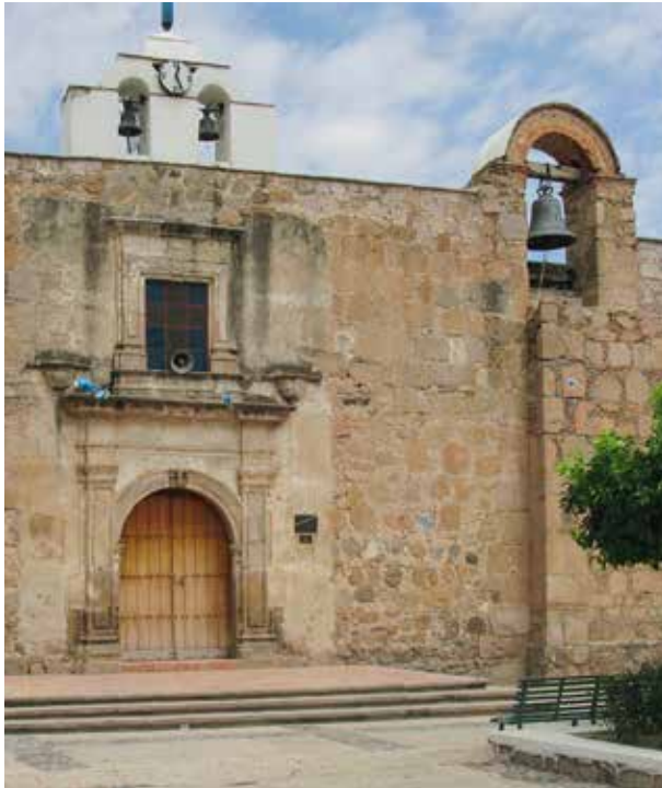
Figura 105. Exterior de la Capilla de Santa Ana Tepetitlán. Fuente: Elaboración propia, 2008.
