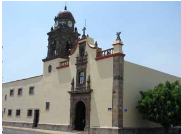
Figura 111. Exterior de la Capilla de San Andrés. Fuente: Elaboración Propia, 2008.
