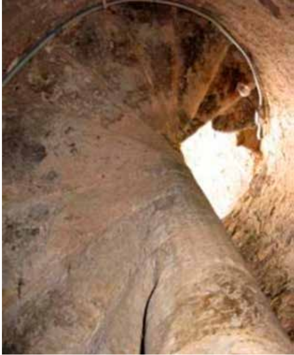
Figura 128. Árbol en la escalera de caracol de la capilla de hospital de Huentitán. Fuente: Elaboración propia, 2008.
