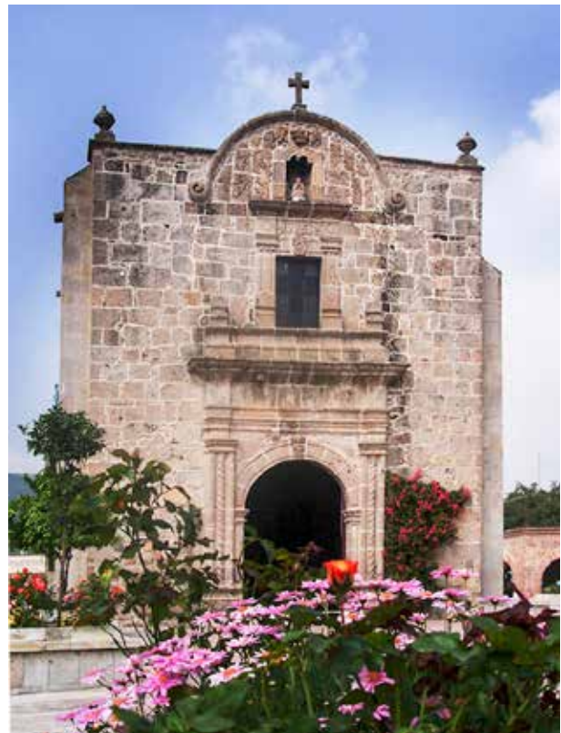
Figura 83. Exterior de la capilla de Tlajomulco. Fuente: Elaboración propia, 2008.
