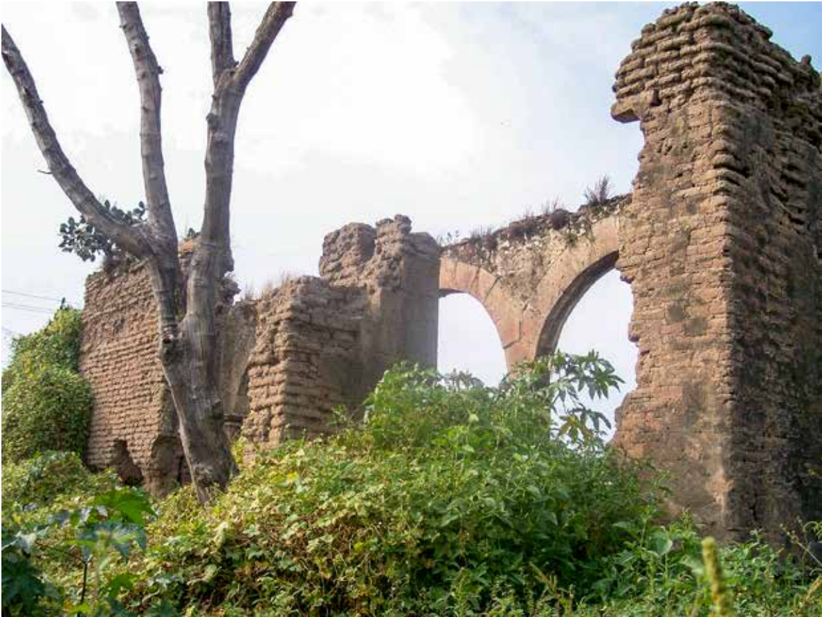
Figura 119. Adobe y cantera, sistema constructivo dominante en la capilla de hospital de San Sebastián el Grande. Fuente: Elaboración propia, 2008.
