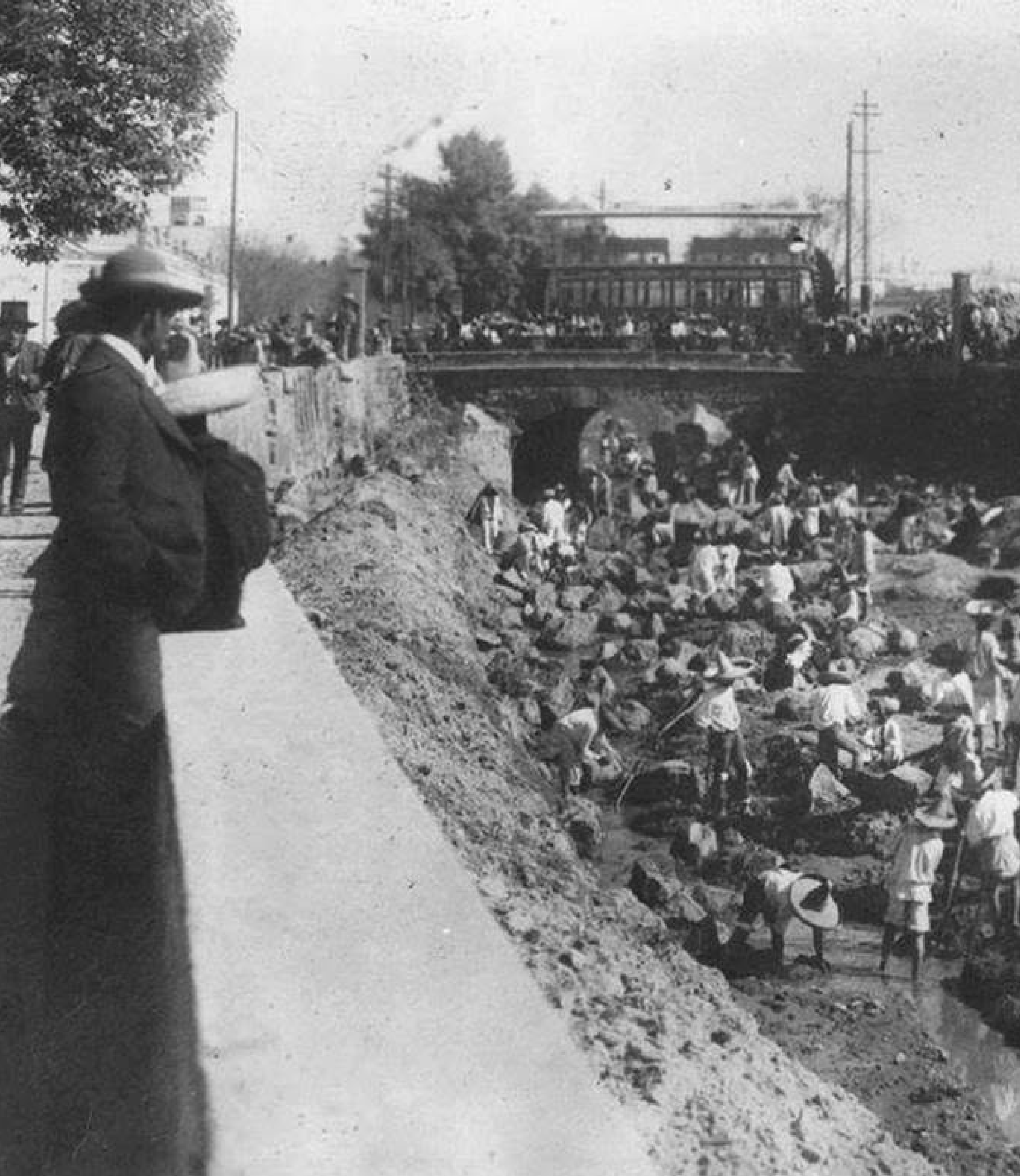
Figuras 1. Obras para el embovedado del río San Juan de Dios, Guadalajara, Jalisco, ca. 1909. Fotografía de José María Lupercio (1870-1927). Nota: vagabunda.mx/el-rio-san-juan-de-dios-sepultado-bajo-una-calzada-que-dividio-a-guadalajara/
