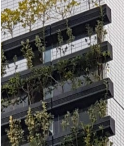
22. Fachada jardín vertical integrada a muro en edificio habitacional. Tokio, Japón
