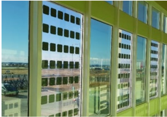
Figs. 8 y 9. Fachada fotovoltaica integrada en ventana termopanel en edificio salud. Punta Arenas Chile
