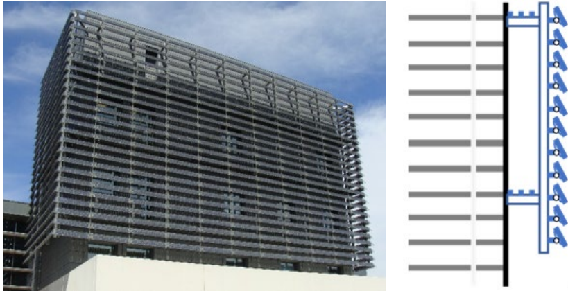
Figs. 12 y 13. Envolvente y detalle de arquitectura integrada como lamas fotovoltaicas de captación y sombra en edificio salud. Madrid, España
