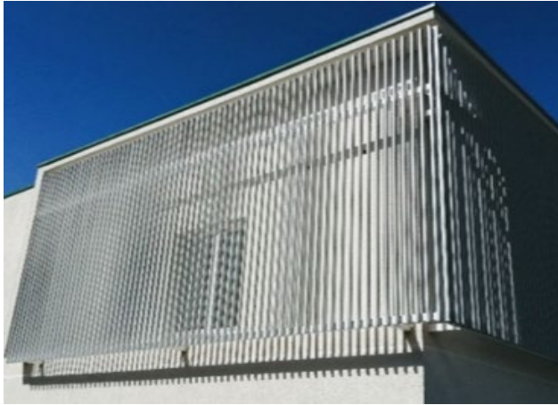
Figs. 17. Sistema sombreado fijo integrado a fachada norte y poniente CESFAM, Antofagasta, Chile
