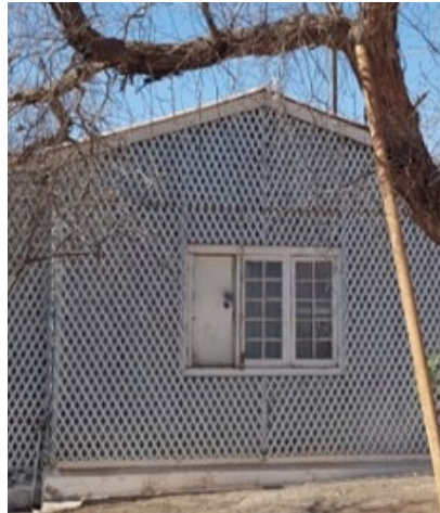
Fig. 25. Fachada treillage de madera soporte de jardín integrada a muro. María Elena, Chile
