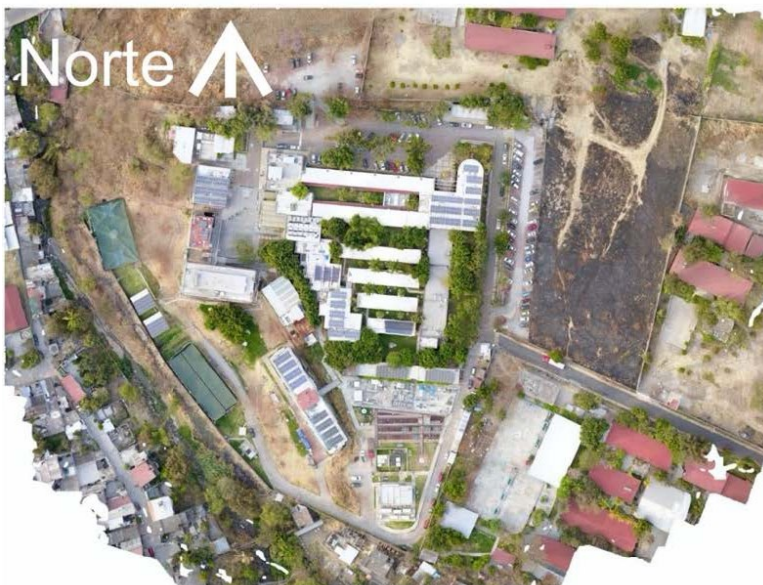
Figura 7. Ortofotografía del IER y del noreste del terreno, donde se ubicará el nuevo proyecto, captada por el dron
