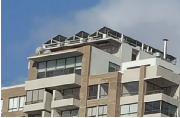
Fig. 4. Instalación fotovoltaica en cubierta de Edificio Habitacional de nueva construcción sector Av. Brasil
