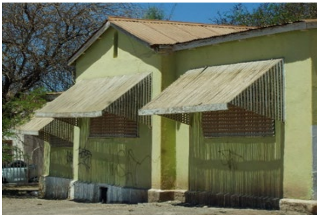
Figs. 16. Alero de sombra, sistema pasivo tradicional integrado a fachada de edificio. María Elena, Chile
