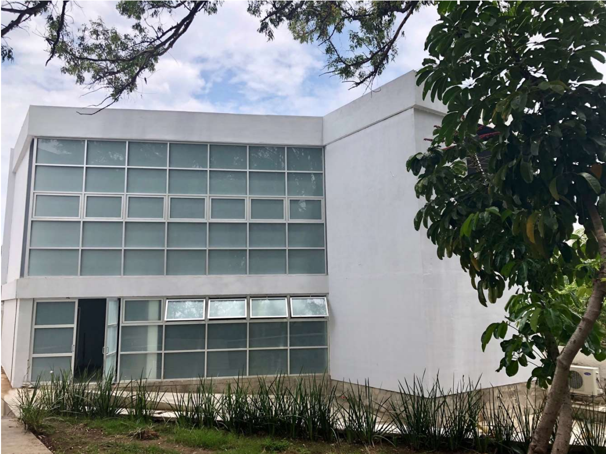
Imagen 2. Edificio de la sede Universidad de Guadalajara del Laboratorio Nacional de Vivienda y Comunidades Sustentables.
