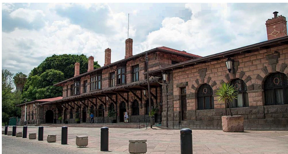
Figura 5. Estación de Querétaro en la actualidad
